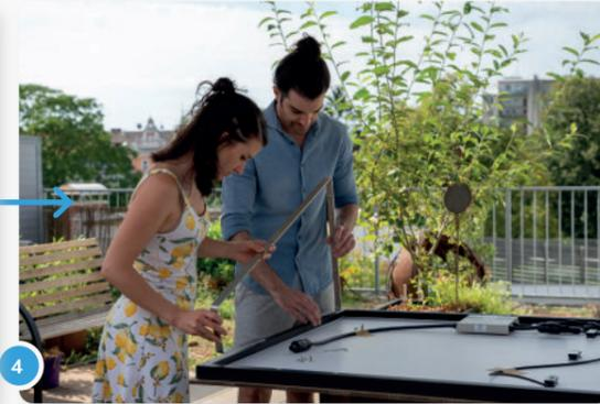
Auf der Rückseite des Modulrahmens findest du Löcher an denen du die Aufsteller festschrauben kannst.
