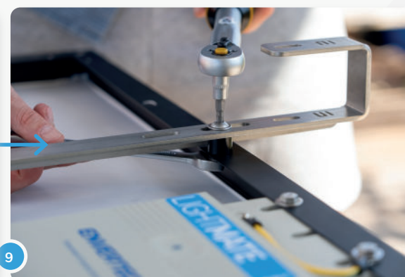
Bitte fixiere die Haken dann mit den Schrauben und Sicherheitsmuttern am Panel. Achte dabei auf das richtige Drehmoment (laut Anleitung),
