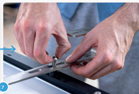
Lege die schwarzen Distanzhülsen aus Kunst- stoff zwischen Haken und Modulrahmen...
