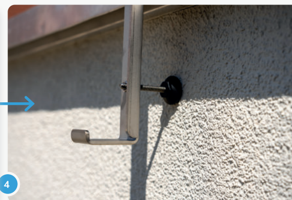
Schraube dafür den Abstandshalter in eine der unteren drei Bohrungen um die Position des Panels auszurichten.
