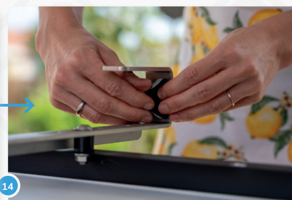
Wenn du einen eckigen Handlauf hast, kannst du jetzt die Gummistreifen als Kratzschutz ein- kleben.
