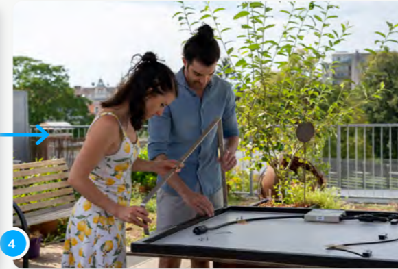
4 Sul retro della cornice del pannello sono presenti dei fori ai quali è possibile avvitare le aste.
