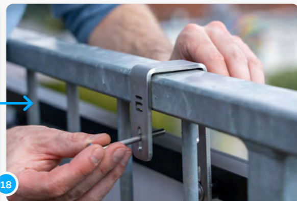
18 ...poi inserire le viti lunghe sotto il corrimano...
