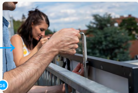
16 Ora appendete i due ganci e il pannello alla ringhiera. Lasciate che vi aiutino!
