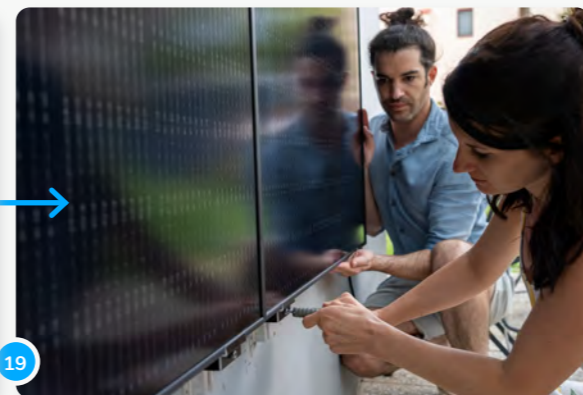
...e, se necessario, stringere leggermente le viti (per ottenere la coppia corretta).
