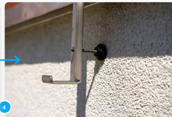
4 A tale scopo, avvitare il distanziale in uno dei tre fori inferiori per allineare la posizione del pannello.
