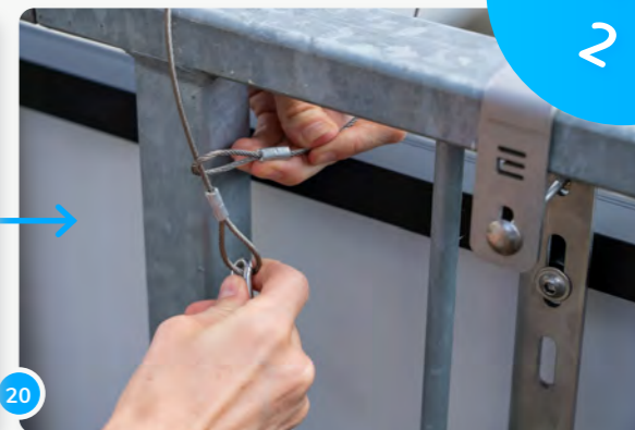
20 Ora fissate la fune di sicurezza in dotazione con un moschettone al centro del corrimano e al pannello.
