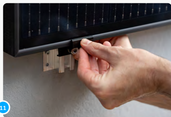
11 I morsetti vengono inseriti nelle guide dall'alto o dalla parte anteriore. Quando vengono premuti, la molla ruota di 90° e scatta in posizione.
