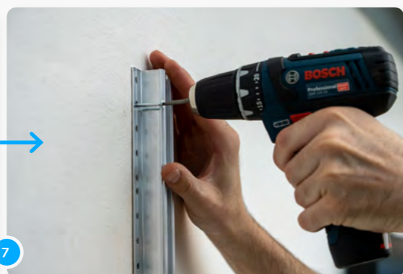
7 Ora è possibile fissare le rotaie con almeno quattro viti (non incluse nella fornitura) per guida. Due viti sulla parte superiore...
