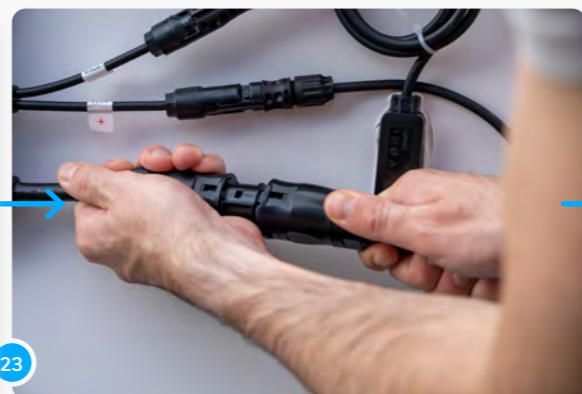
23 Se avete deciso di utilizzare LightMate G+, è ora possibile collegare i due inverter.
