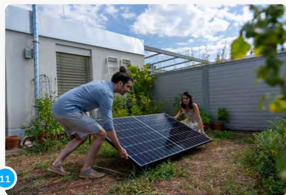
11 Quando hai trovato un luogo adatto, è possibile fissare il pannello al suolo...
