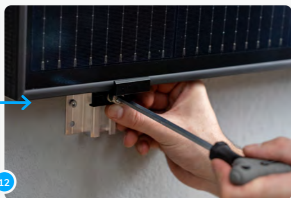
12 Quando la pinza è nella sua posizione finale è possibile fissarlo in posizione utilizzando le viti e una chiave dinamometrica. (la coppia corretta è specificata dal produttore)
