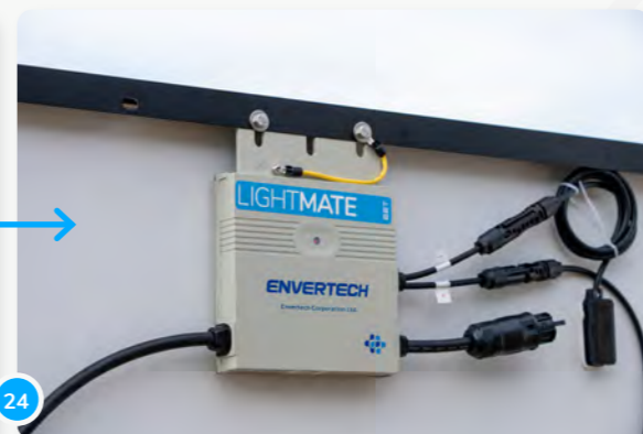
24 L'inverter viene fornito già avvitato al pannello.
