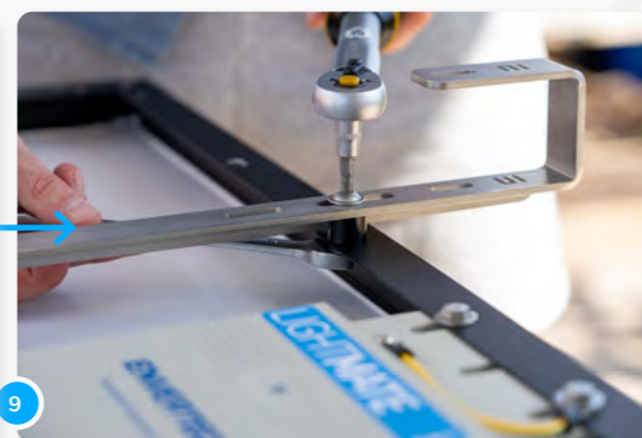
9 Fissare quindi i ganci al pannello con le viti e i dadi di sicurezza al pannello. Prestare attenzione alla coppia corretta (secondo le istruzioni).
