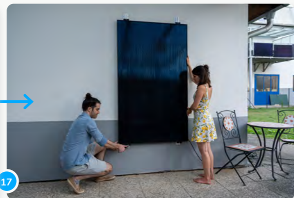
Quando il pannello viene fissato...
