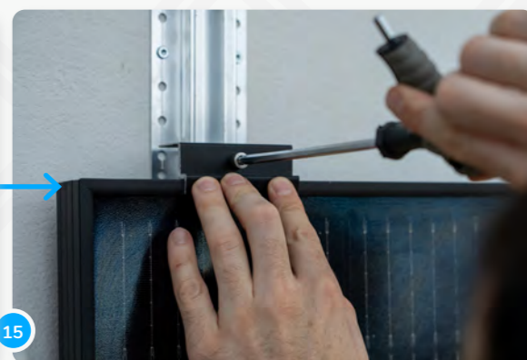
15 ...fissare (presta attenzione alla coppia corretta)...
