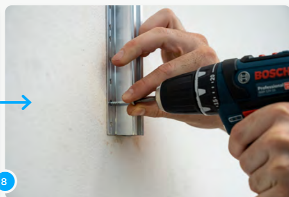
8 ...due viti nella parte inferiore.
