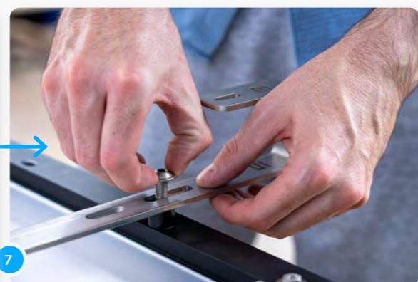
7 Posizionare i manicotti distanziatori in plastica nera tra il gancio e il telaio del modulo...
