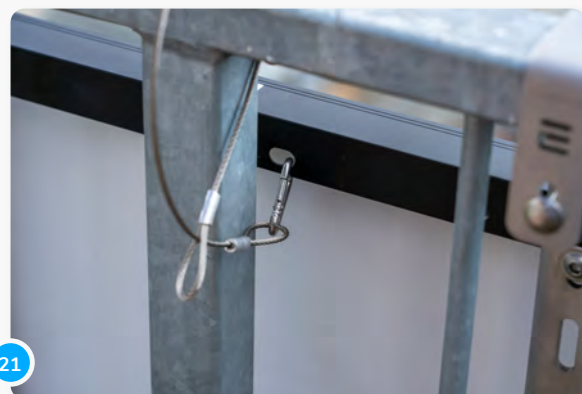
21 Assicuratevi che la chiusura del moschettone non sia rivolta verso la cornice del modulo.
