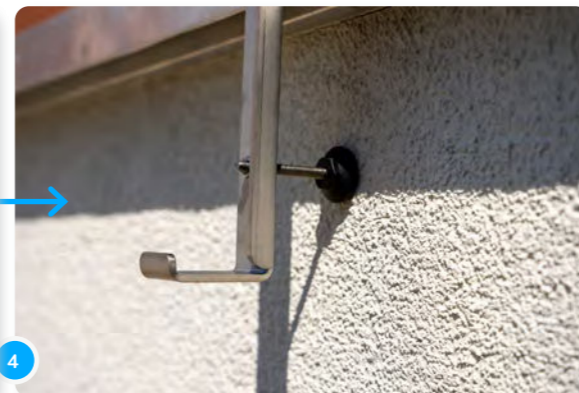
Pour cela, visse l'entretoise dans l'un des trois trous inférieurs pour ajuster la position du panneau
