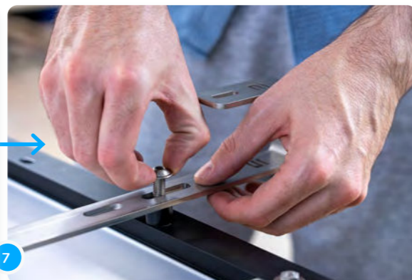
Place les douilles de distance en plastique noir entre le crochet et le cadre du module...
