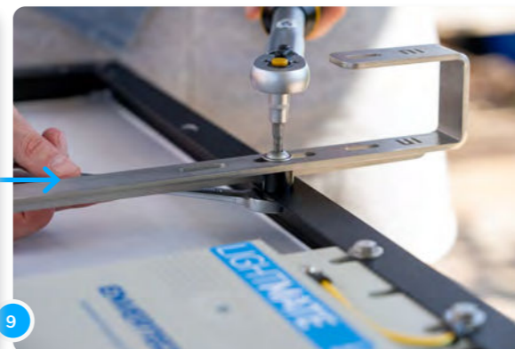
Fixe ensuite les crochets sur le panneau à l'aide des vis et des écrous de sécurité. Veille à ce que le couple de serrage soit correct (selon les instructions),
