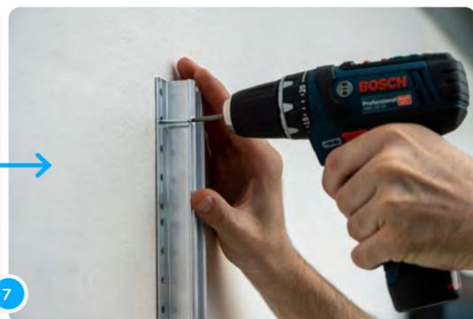
7 Fixe maintenant les rails avec au moins quatre vis par rail (les vis ne sont pas incluses dans la livraison). Deux vis en haut...
