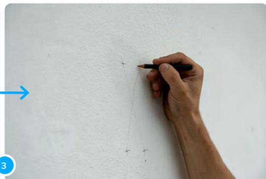
3 Détermine où tu veux installer les rails afin qu'ils puissent être vissés au mur les uns parallèles aux autres.
