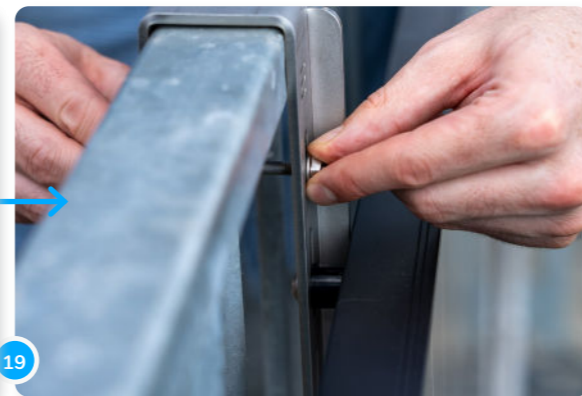
19 ... y aprieta firmemente sin doblar los ganchos.
