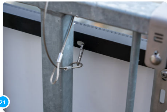
21 Asegúrate de que el cierre del mosquetón no esté apuntando hacia el marco del módulo mientras lo haces.
