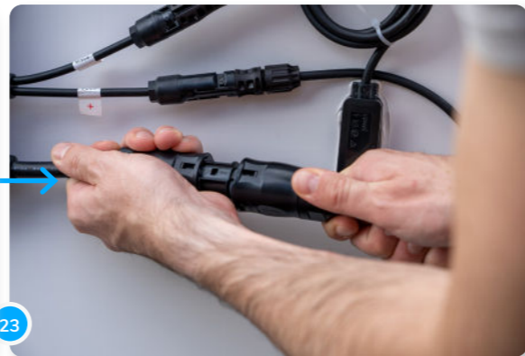
23 Si ha elegido LightMate+, ahora puedes conectar los dos inversores juntos.
