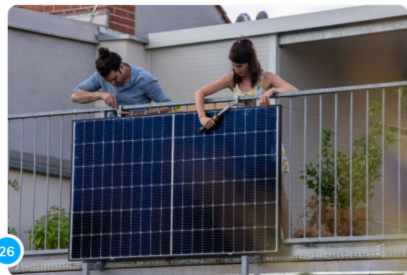
26 Ahora puedes revisar nuevamente todos los tornillos y apretarlos más fuerte si es necesario...
