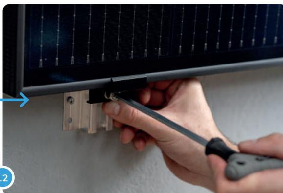
12 Quand la pince se trouve dans la position définitive, tu peux la fixer avec les vis et une clé dynamométrique (le couple de serrage à respecter est indiqué par le fabricant).
