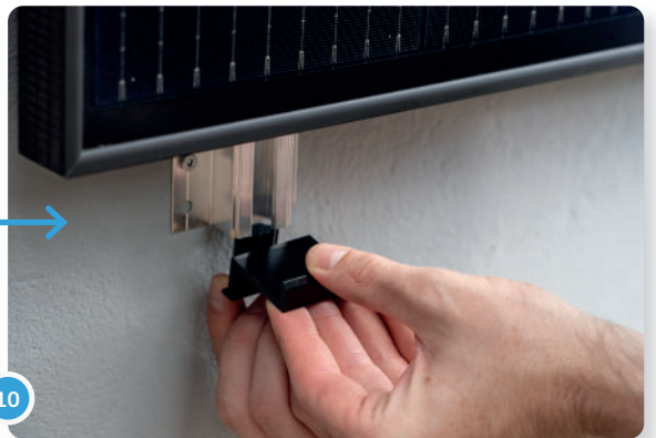
Coloca ahora el panel en la posición deseada y pide ayuda a alguien para sujetar las abrazaderas mientras las fijas.
