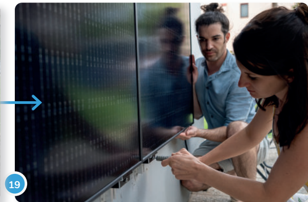
...y aprieta los tornillos según sea necesario (para alcanzar el torque correcto).
