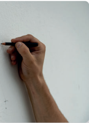
...los perfiles para que se alineen a la pared.
