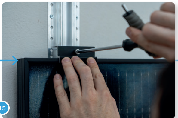
...aprieta los tornillos (presta atención al torque correcto)...
