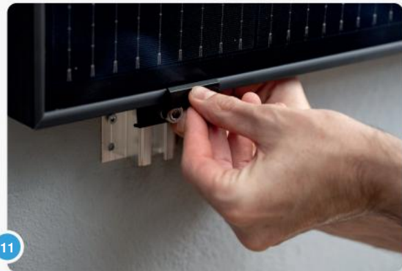
11 De klemmen worden van bovenaf of van voren in de rails gedrukt. Wanneer u deze indrukt, draait de veer 90° en klikt op zijn plaats.
