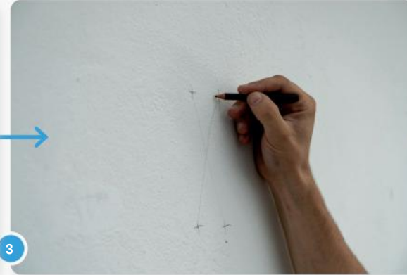
3 Bedenk waar je de profielen gaat bevestigen, zodat ze evenwijdig aan elkaar aan de muur geschroefd kunnen worden.
