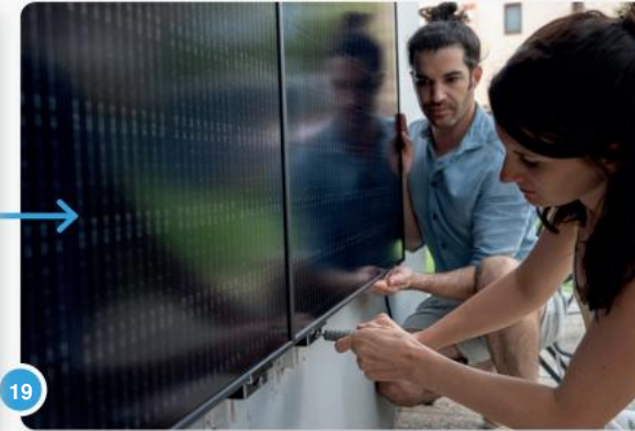
...en draai de schroeven indien nodig iets aan (om het juiste aanhaalmoment te bereiken).
