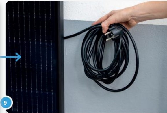
9 Zorg ervoor dat u de voedingskabel via de achterkant naar buiten leidt voordat u de panelen bevestigt, zodat deze later klaar is om te worden aangesloten.
