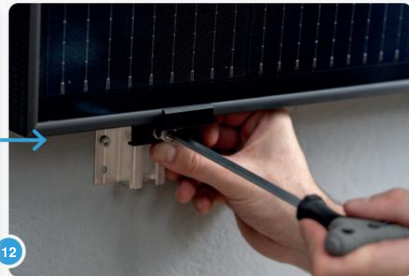
12 Wanneer de klem in de definitieve positie staat, kunt u deze vastzetten met behulp van de schroeven en een momentsleutel. (Het juiste aanhaalmoment wordt gespecificeerd door de fabrikant.)
