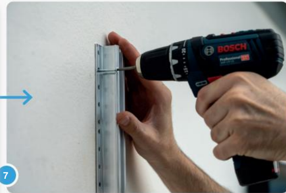
7 Nu kun je de rails monteren met minimaal vier schroeven (niet meegeleverd) per rail. Twee schroeven aan de bovenkant...
