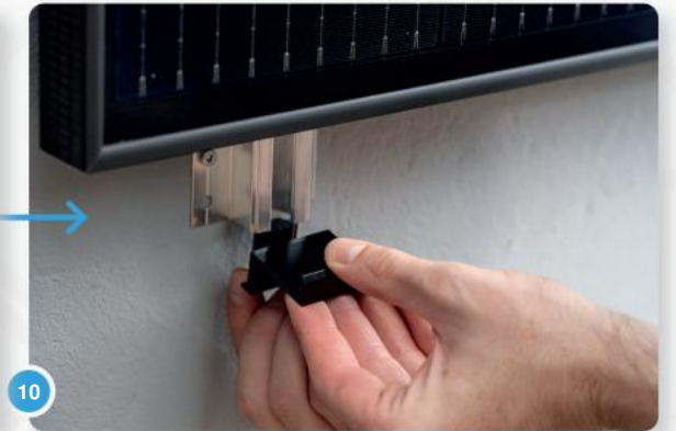
10 Zet nu het paneel in de gewenste positie en laat iemand je helpen met het bevestigen van de klemmen.
