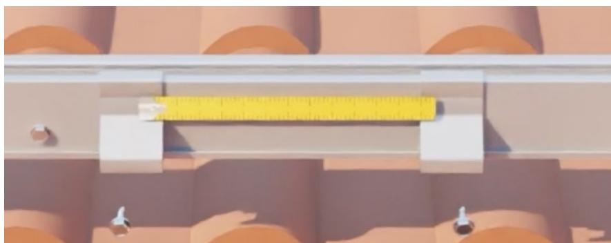
Nun können Sie diese Aufnahmen mittels selbstschneidender Schraube an der Schiene befestigen.
